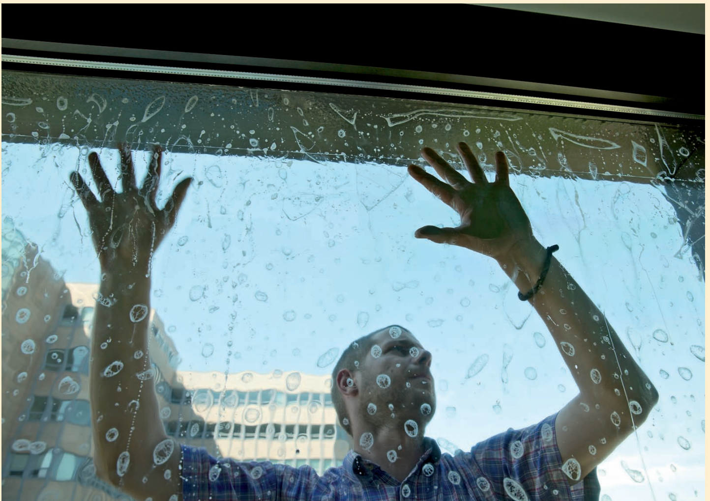
Das Applizieren und Positionieren des Sonnenschutzfilms 3M Prestige 70 Exterior im Hotel Inside in Frankfurt-Niederrad durch das Expertenteam der Firma Audax erfordert große Fachkompetenz und die Kenntnis modernster Verlegetechniken.
